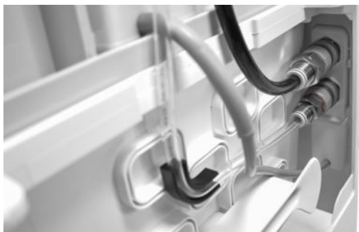
Abb. 7.4.2.7: Anschluss Stromkabel, AWZ & Spülvorrichtung
