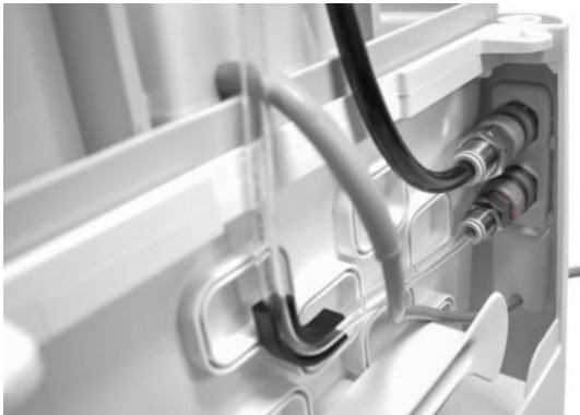
Abb. 6.3.4.12: Anschluss Stromkabel, AWZ & Spülvorrichtung
